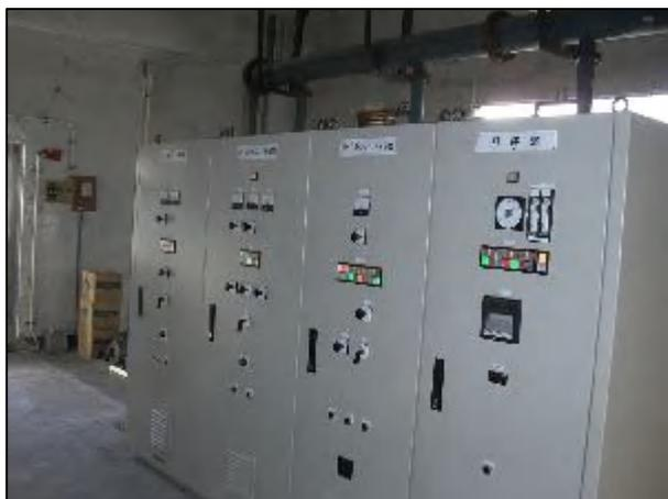
写真 3.3 配水ポンプ制御盤
