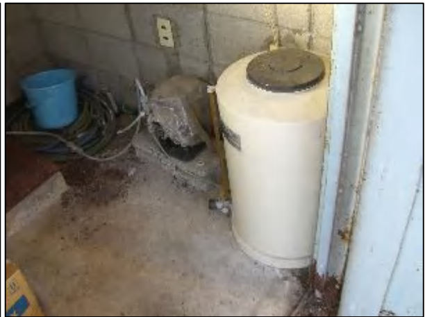
写真 3.8 薬品注入設備
