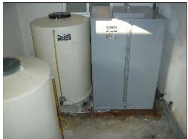
写真 3.12 薬品貯蔵タンク
