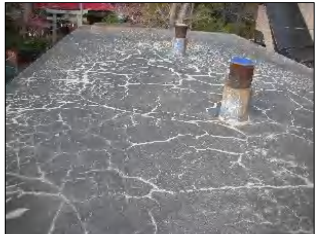
写真 3.10 配水池の頂版
