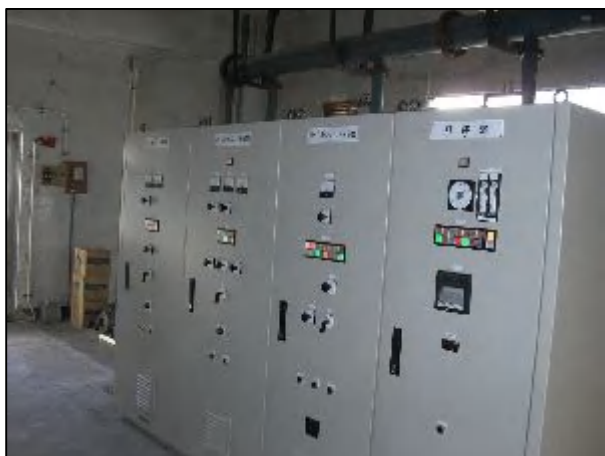
写真 3.3 配水ポンプ制御盤
