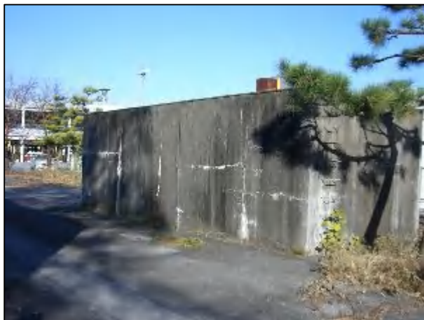
写真 3.1 ひび割れ及びエフロレンス
