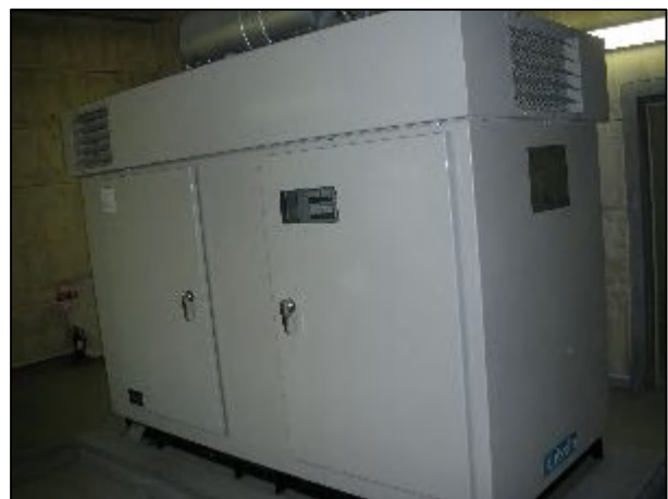
写真 3.16 自家用発電機設備
