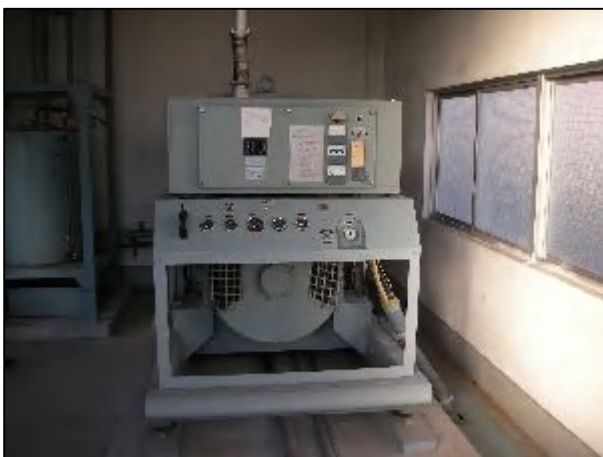
写真 3.11 自家用発電機設備
