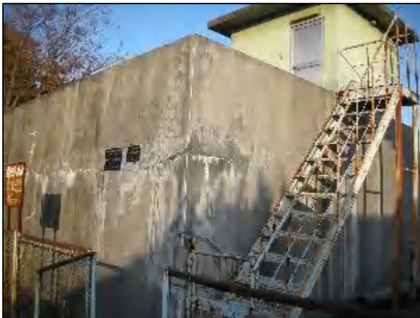
写真 3.9 配水池の劣化状況
