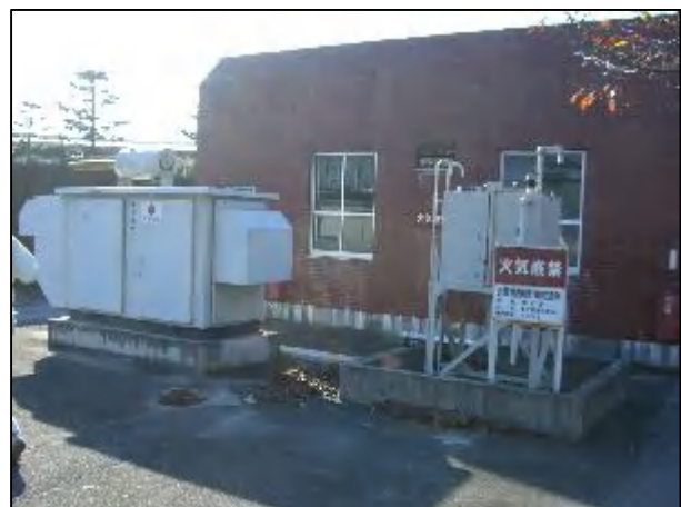
写真 3.4 自家用発電機設備
