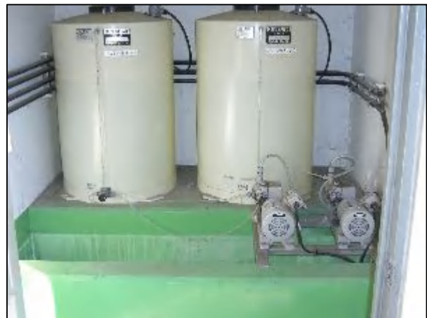
写真 3.2 薬品注入設備
