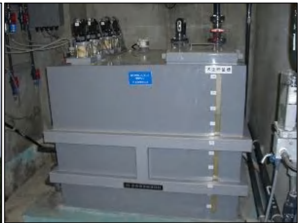
写真 3.14 薬品貯蔵タンク
