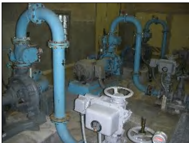
写真 3.15 配水ポンプ設備
