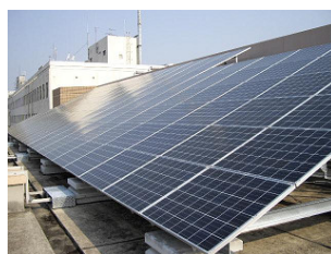
太陽光パネル (横浜市神奈川区)
