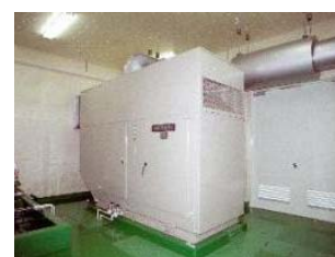
自家発電装置 (神奈川県足柄上合同庁舎)
