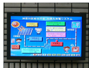
発電量モニタ (横浜市神奈川区)
