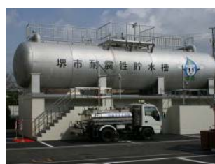
耐震性貯水槽 (堺市上下水道局)
