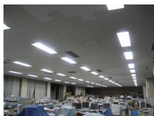
照明LED化(山武市)
