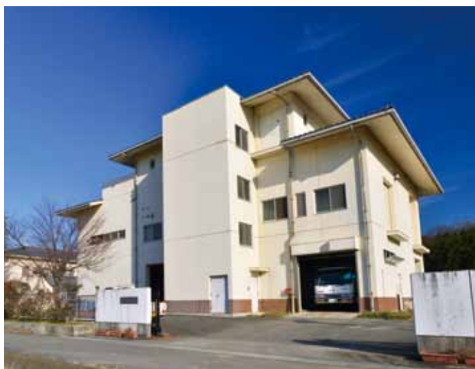
とよみクリーンセンター外観
