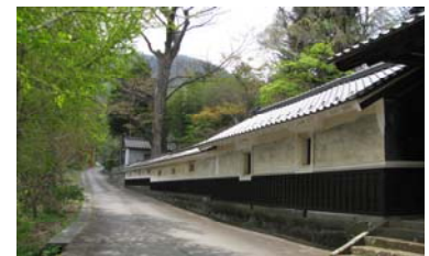
・関原の古民家の土塀
