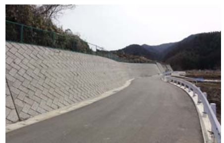
・里山景観の中で目立つ土木構造物
