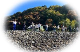
石積み出し 3 番堤
