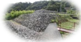
石積み出し 1 番堤
