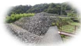
石積み出し 1 番堤
