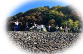
石積み出し 3 番堤
