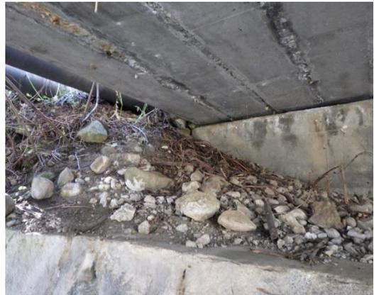
写真-2.4 支承部の土砂詰り
