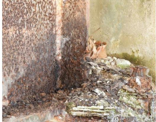
写真-2.2 鋼桁・支承の腐食、防食機能の劣化
