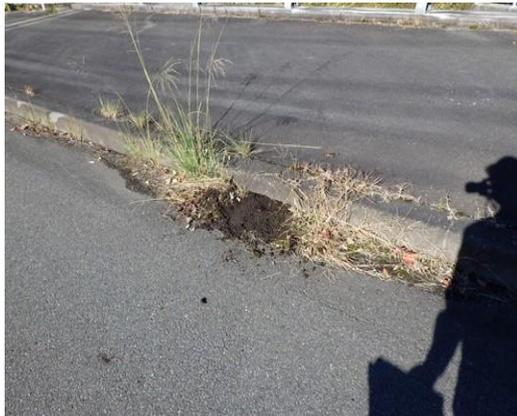
写真-2.3 排水ますの土砂詰り
