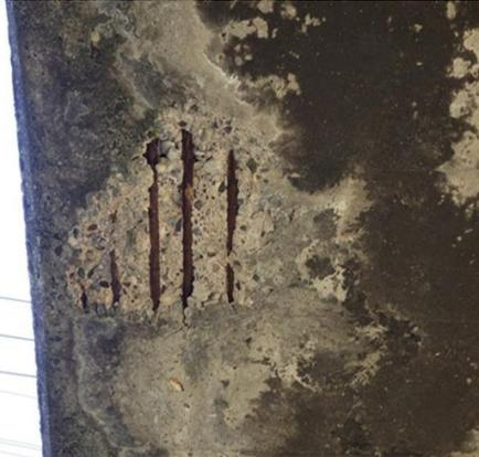
写真-2.1 橋脚の剥離・鉄筋露出
