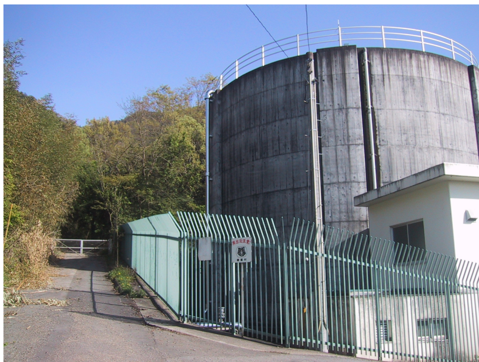
第2配水場の様子（汲み上げた地下水は浄水後、自然流下方式により配水します）
