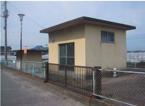
【鍛冶新居配水場】
