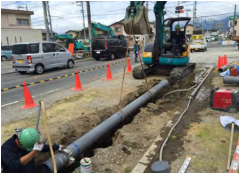
【配水管布設状況】
