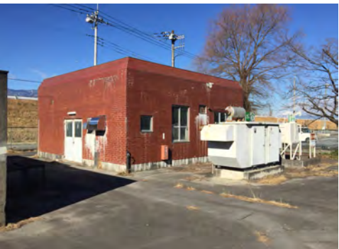
【リバーサイド配水場】
