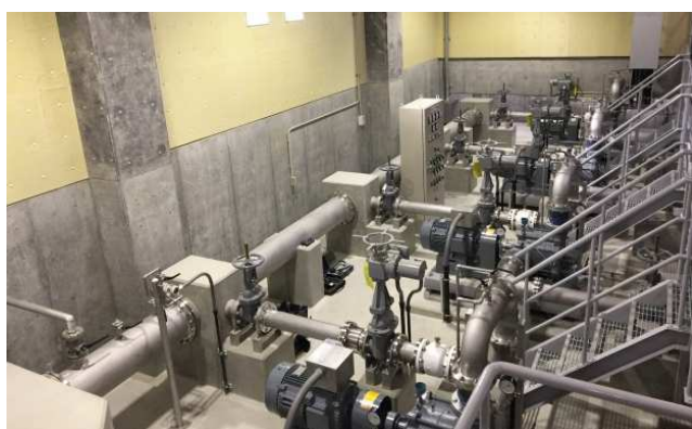
【インバータ制御配水ポンプ（布施配水場）】
