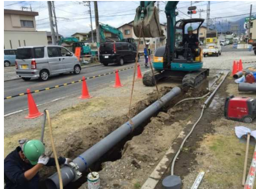
配水管布設工事状況
