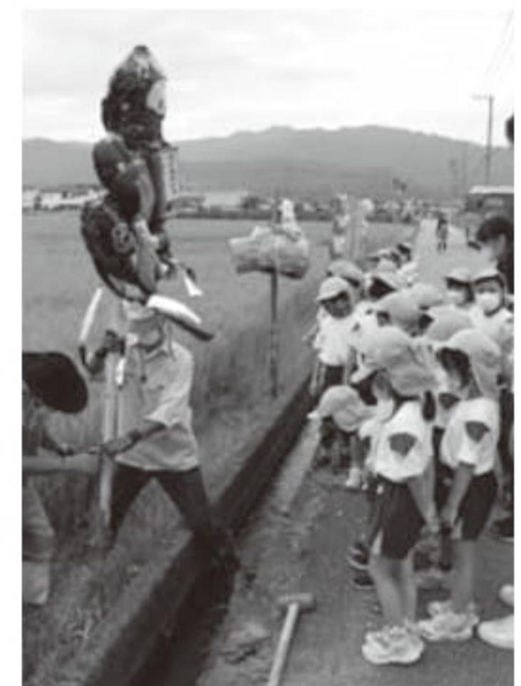
取り付け作業を見学中
