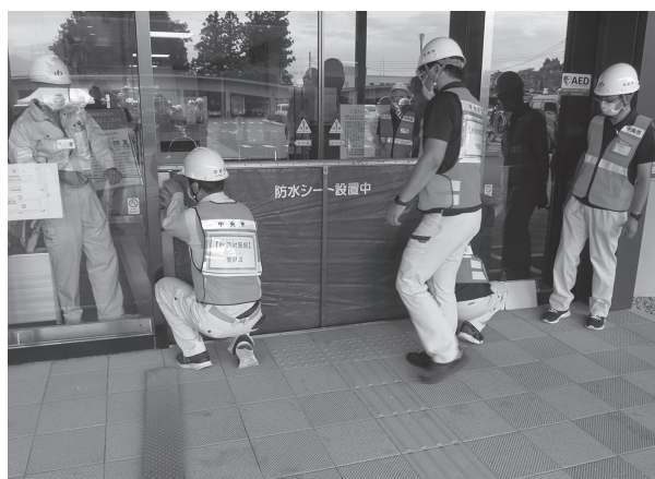
市役所本館入口での防水シート設置訓練
