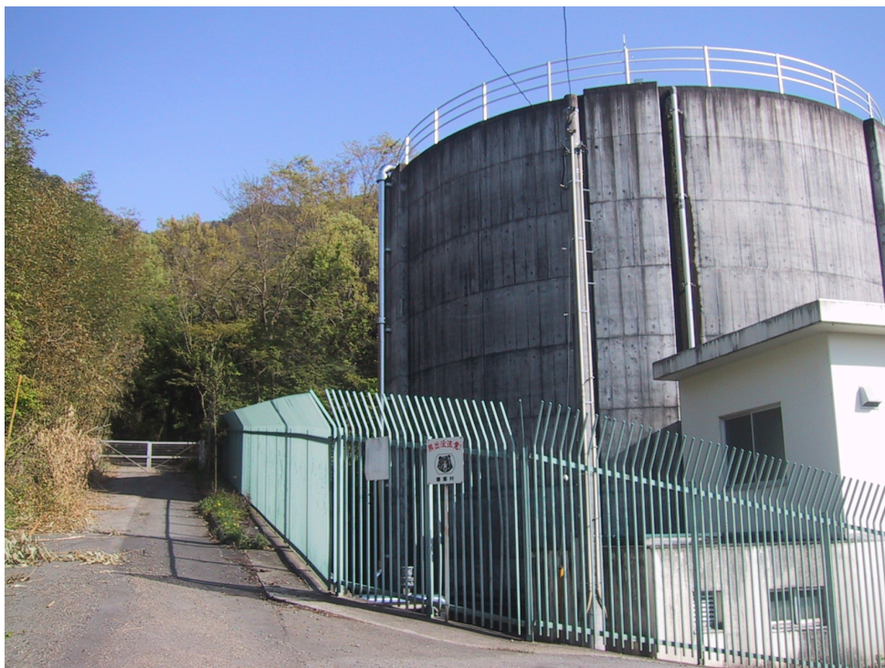
第2配水池の様子（汲み上げた地下水は浄水後、自然流下方式により配水します）
