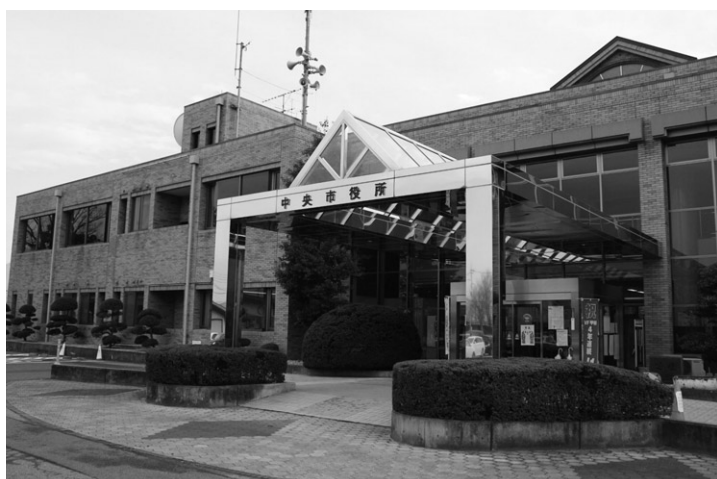
本庁舎として増改築される田富庁舎
