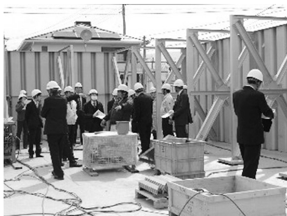
建設中の布施配水場
