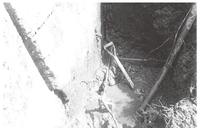
漏水工事の現場
