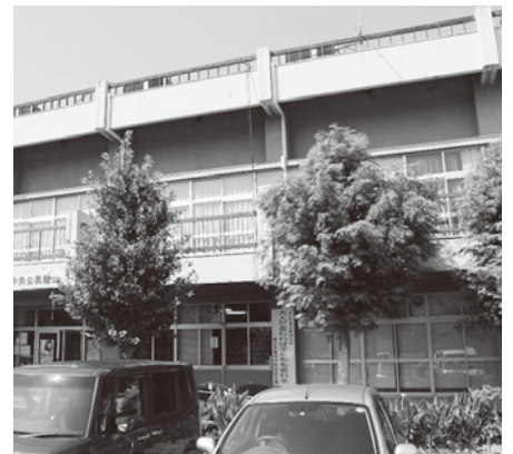
解体し豊富庁舎内に再整備される予定の 豊富中央公民館
