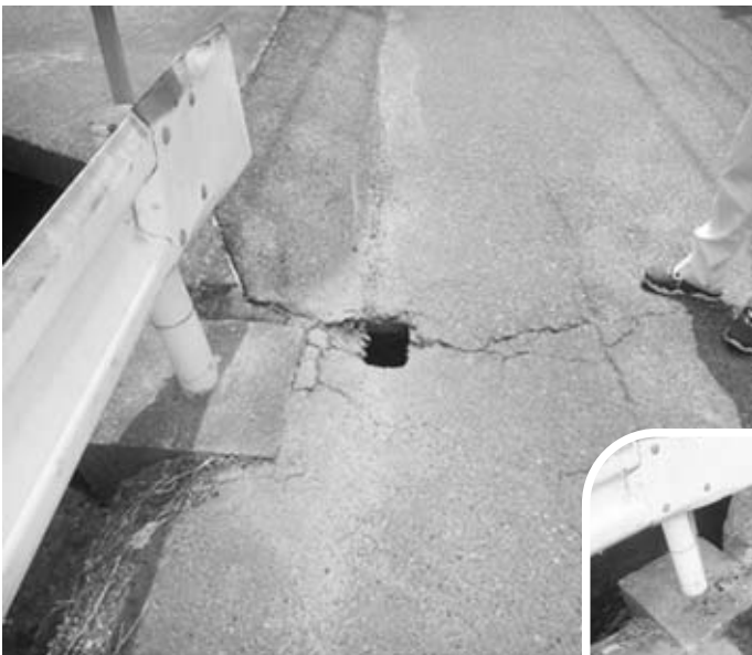
道路の陥没と補修のようす
