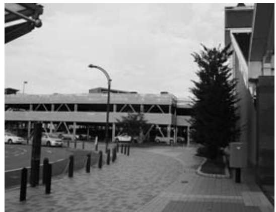
駅の北口に整備された大型立体駐車場
