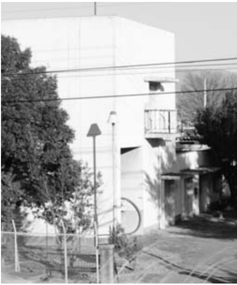
田富よし原処理センター
