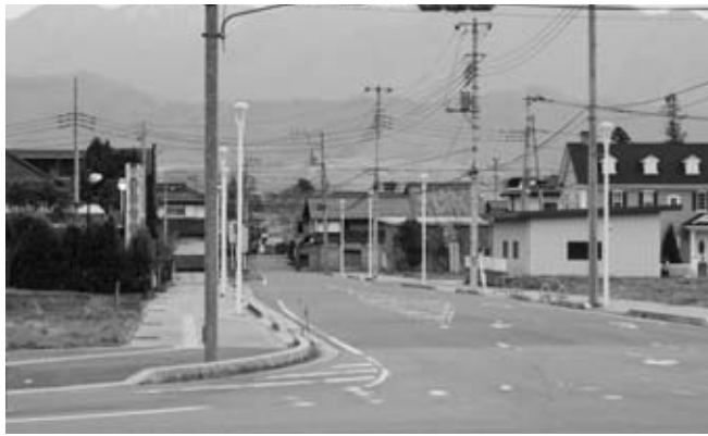
整備される玉穂中央通り線（南部）
