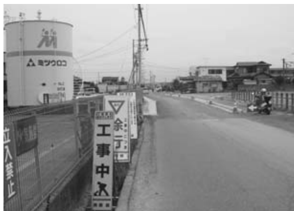
整備中の田富I-6号線(東花輪駅前の北西)
