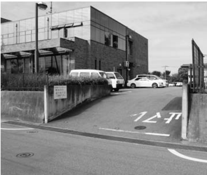
歩道を設置し傾斜を緩やかにする予定の田富庁舎東南入口
