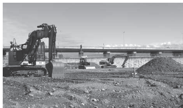
防災公園工事現場
