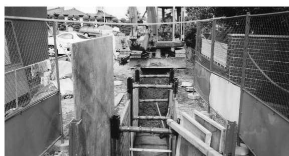
生活環境の改善 下水道工事(玉穂地内)
