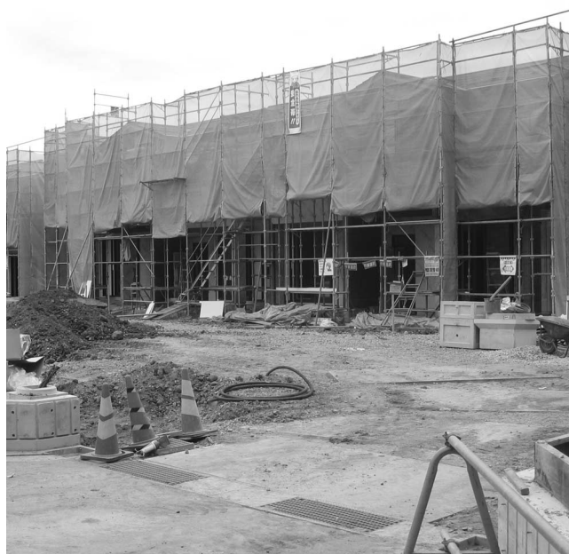
建設中の神明団地市営住宅(豊富地内)
