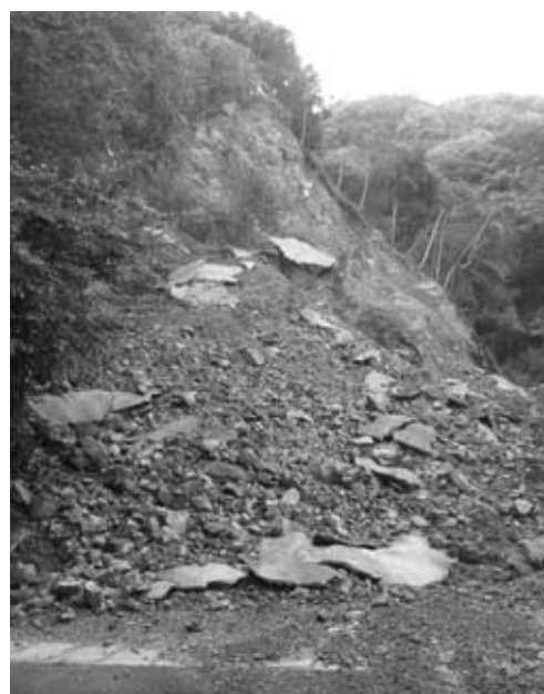
10月の台風により崩落した大鳥居林道
