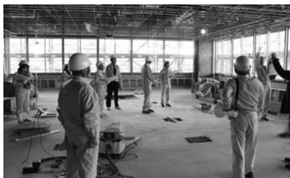
2階の防災対策室
