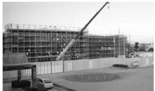
建設中の増設庁舎
