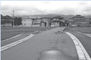
田富玉穂大津線の 今年度着工予定現場
