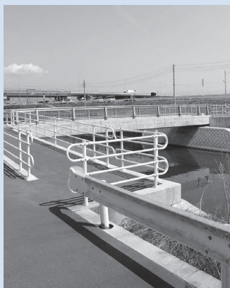
移設された人道橋
