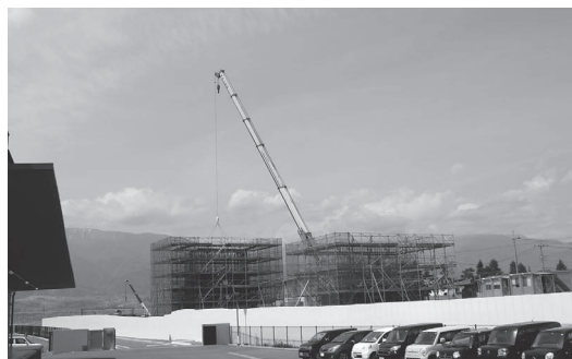
田富北小跡地では橋脚の工事が進められている
