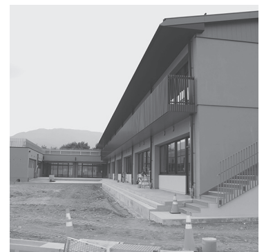
完成間近の田富北小学校
