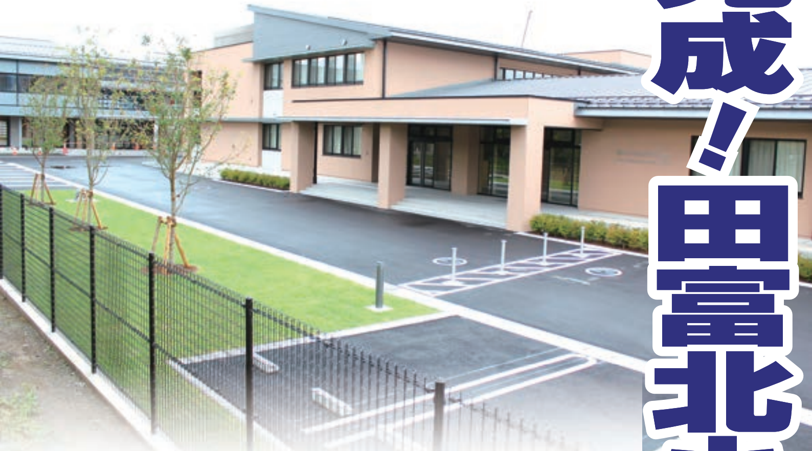
完成した田富北小学校新校舎（正面玄関）
