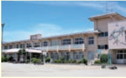
長寿命化が実施される田富小学校
