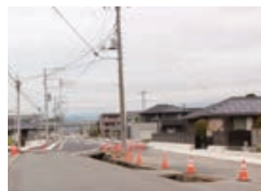
工事が進む玉穂中央通り線
