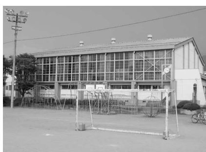
来年度改築予定の 豊富小学校体育館
