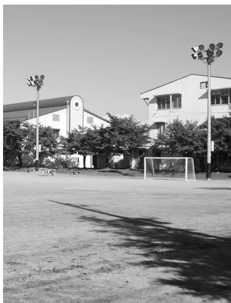
完成した夜間照明(田富南小)
