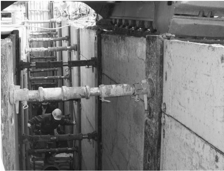
下水道工事(田富庁舎付近)
