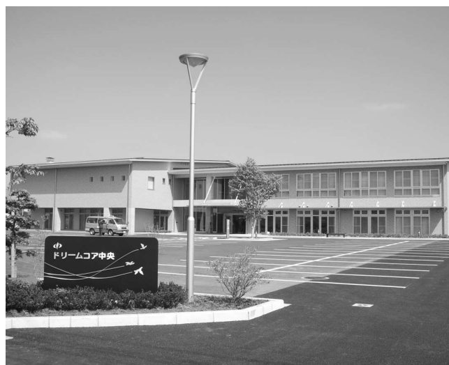
竣工した「ドリームコア中央」
