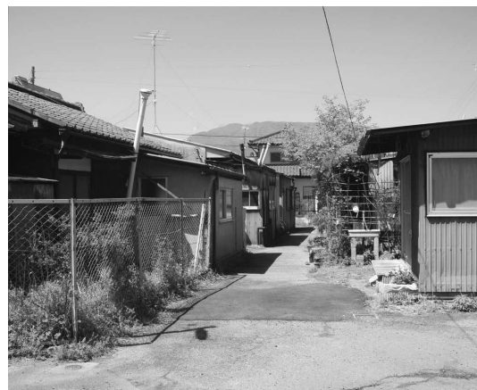
老朽化の進む市営住宅
