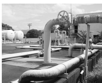
田富リバーサイド地区よし原処理場
