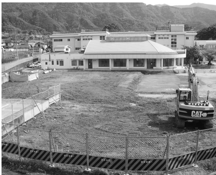
豊富小学校体育会建設現場
