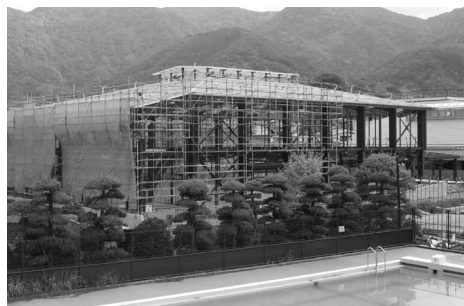
建設工事が進む 豊富小学校屋内運動場
