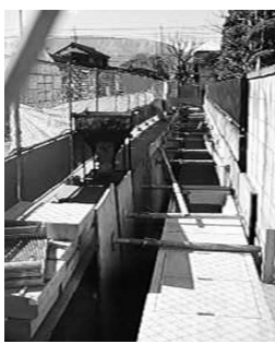
冠水対策のための排水路工事（布施地区）
