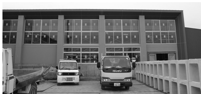
建設中の中学校武道場
