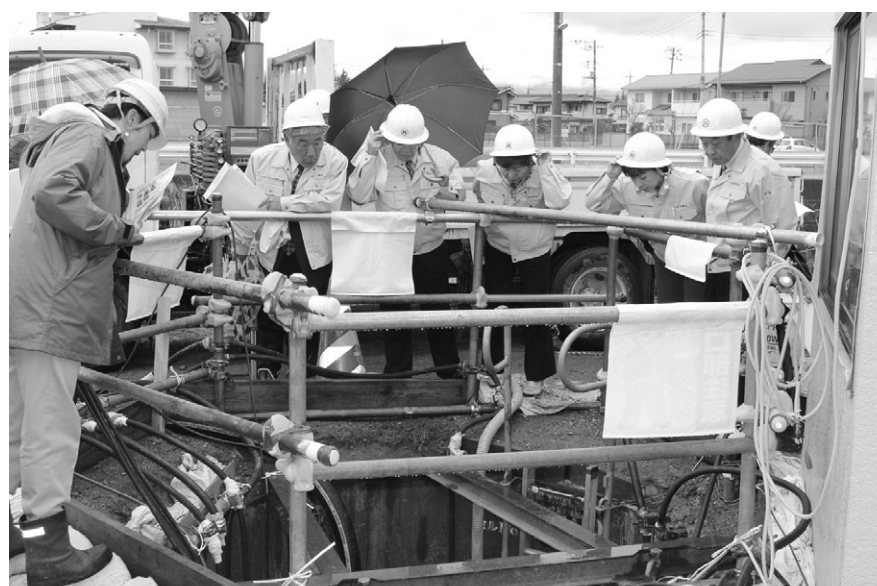
現地で視察した公共下水道工事
