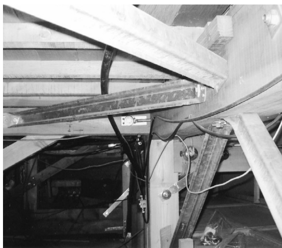
耐震改修を行っている天井のはり補強の様子
