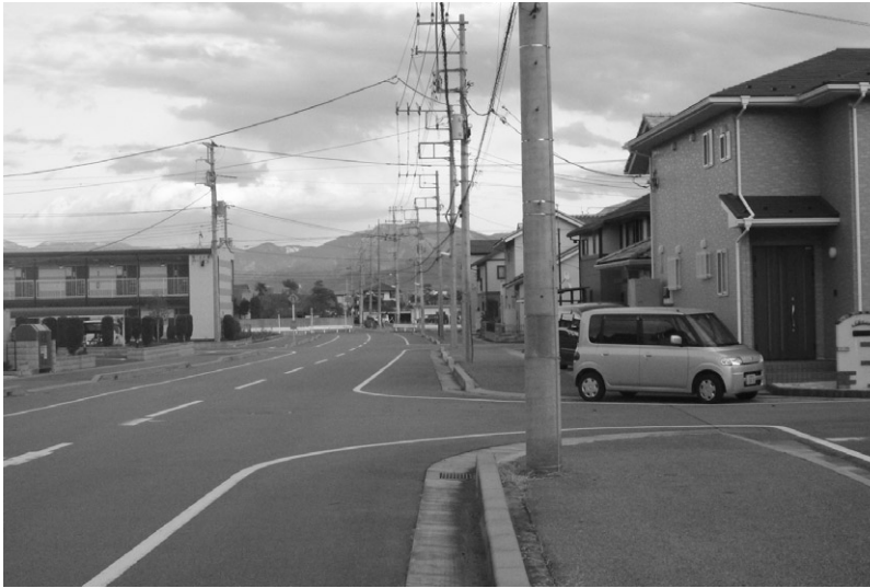
市道に設置されている電柱等には占用料がかかります
