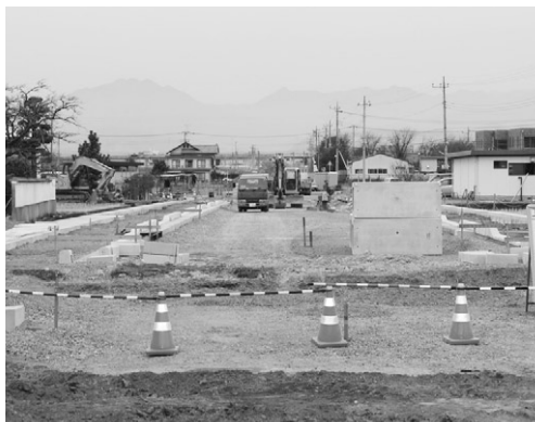
築造工事中の市道田富西通り線
