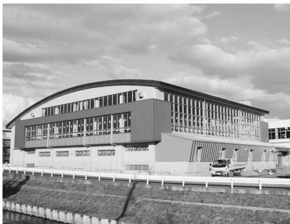
完成間近の三村小学校屋内運動場
