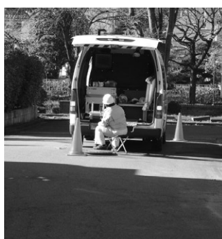
よし原処理区域内 管渠テレビカメラ調査の様子
