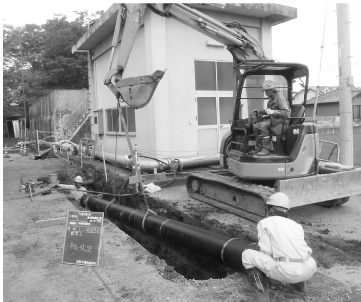
水道管の耐震管への布設替工事
