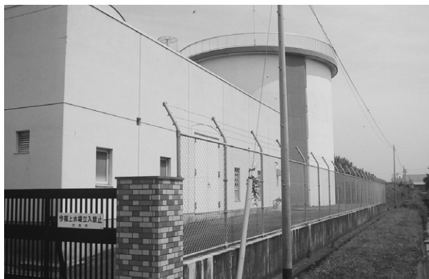
市の南部に配水している今福配水場
