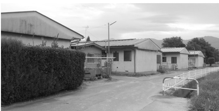
建て替えが検討されている市営町之田団地
