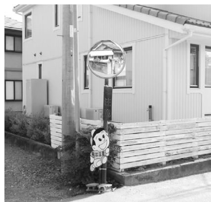
カーブミラー修繕前（新町地区）
