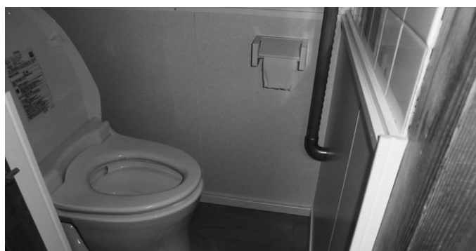
介護用に改修したトイレ
