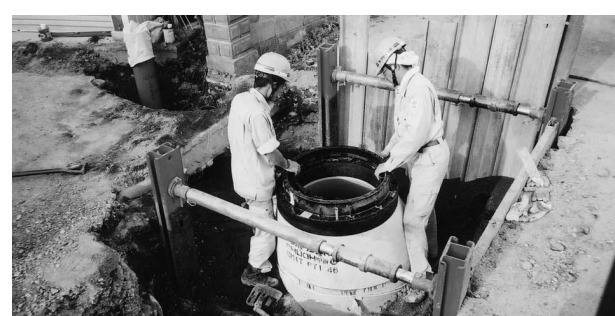
下水道工事(井之口地内)
