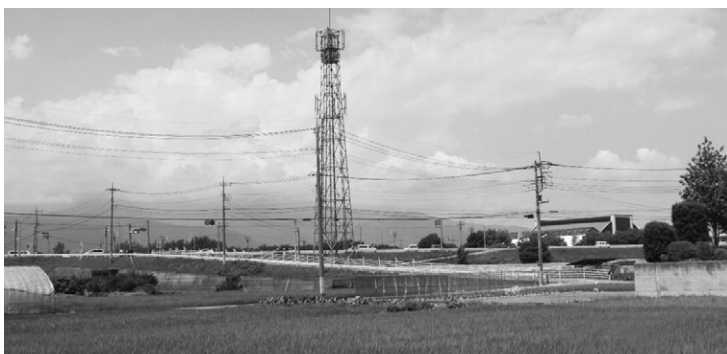
学校周辺の電波塔
