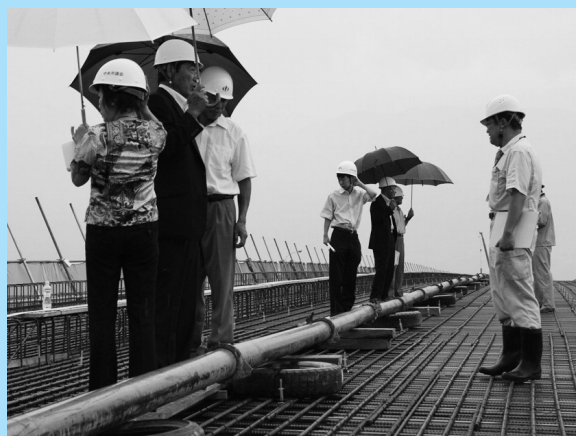
建設中の浅原橋
