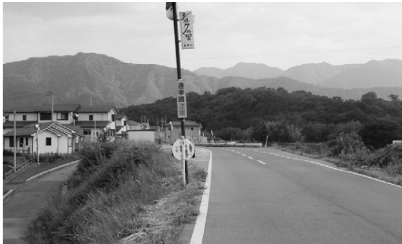
転落防止措置をした通学路
