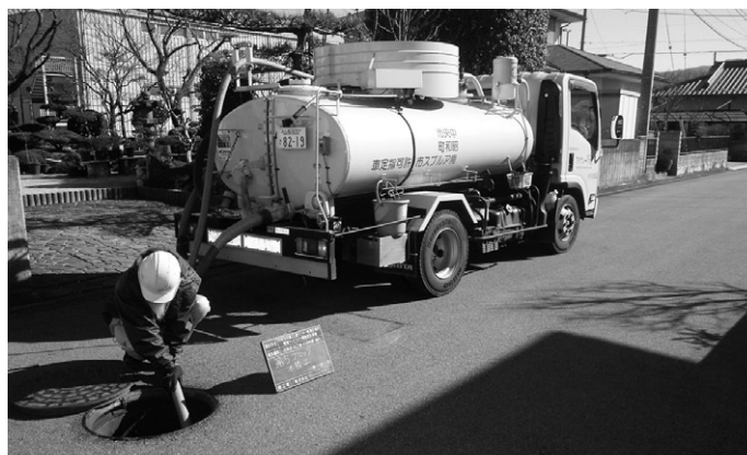
リバーサイド地内の下水道管調査
