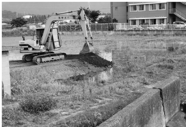
建設中の地域密着型サービス拠点施設
