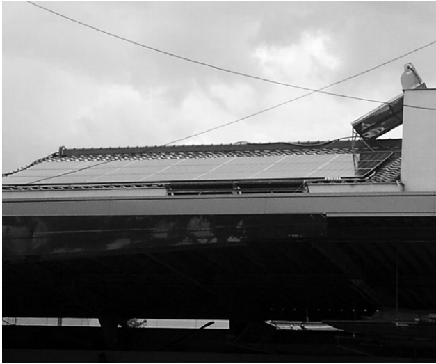
店舗に設置された太陽光パネル
