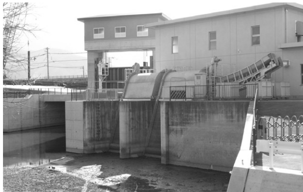
完成した排水機場（大田和）
