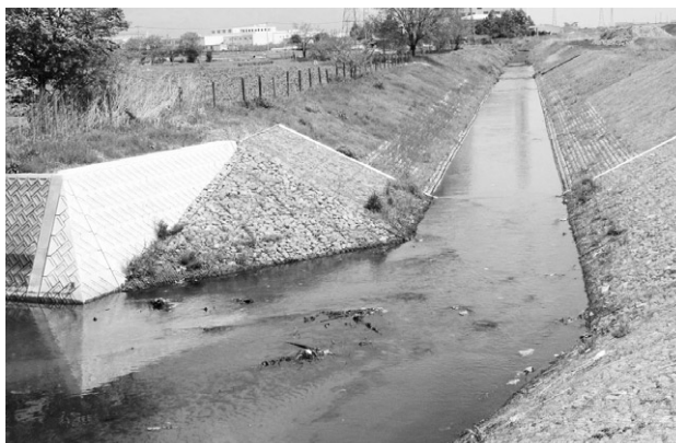
改修が進んでいる東花輪川
