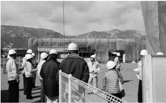
田富第1保育園大規模改修
